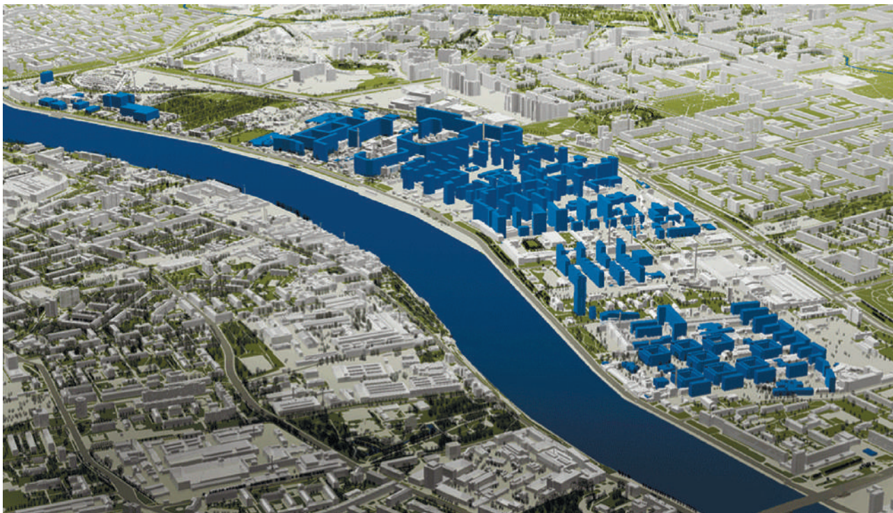
Рис. 2. Фрагмент 3D-модели Санкт-Петербурга. Визуализация проектных решений по инвестиционно-строительному развитию правого берега р. Невы [6]
