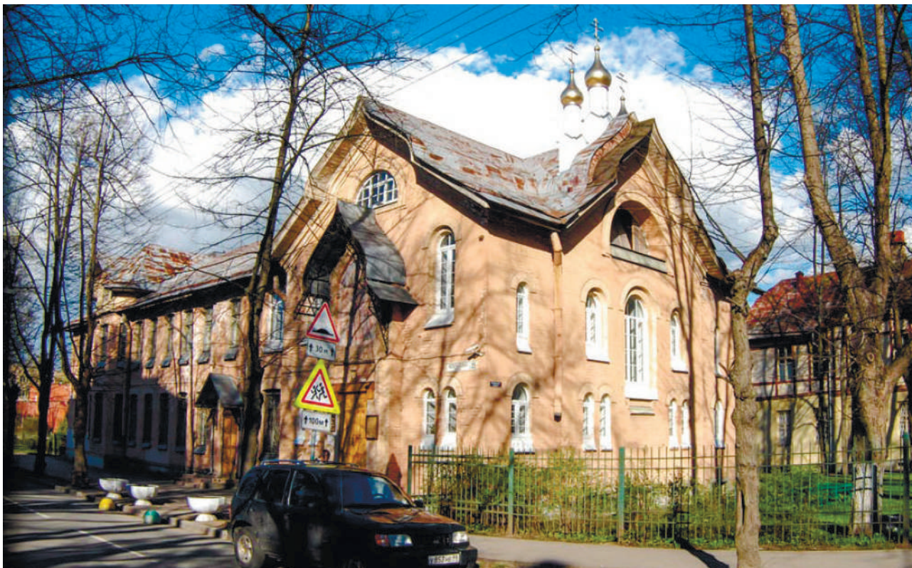
Рис. 2. Современный вид храма «Всех скорбящих Радость» на Леонтьевской, 35, в г. Пушкине
